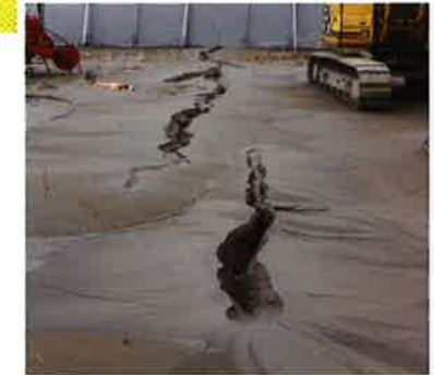
液状化による噴砂
