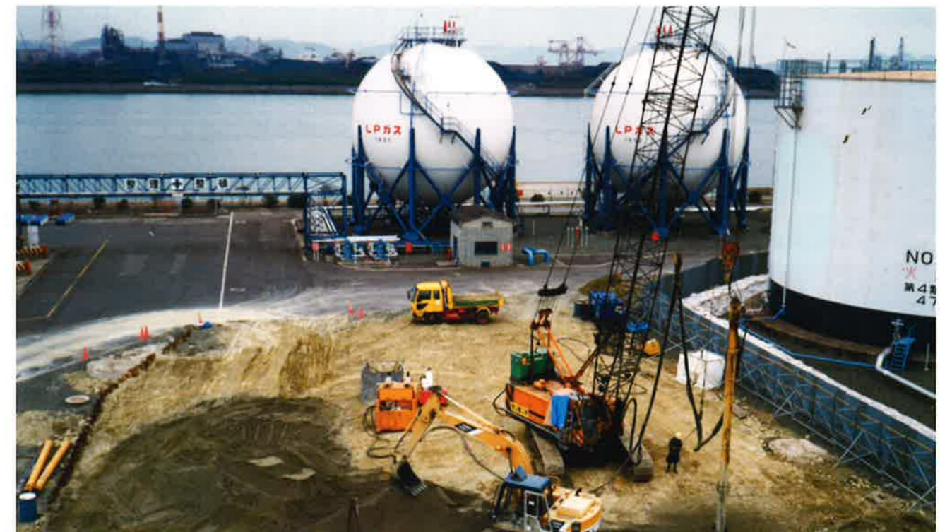
移動中のタンク施設周辺での液状化対策事例
