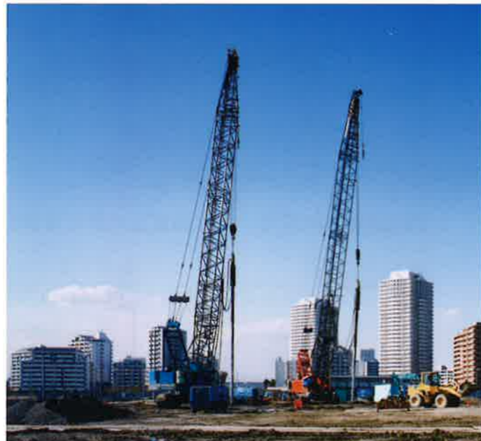
湾岸地域の埋立地盤の液状化対策事例
