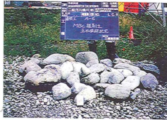
玉石破碎状況 GL-32m
