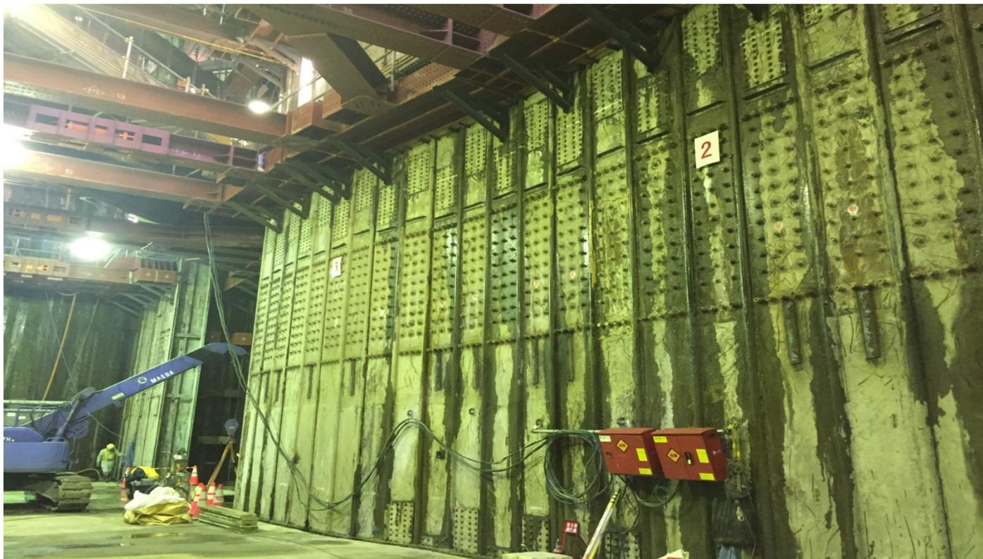
CSM工法で施工したソイルセメント鋼製連壁壁面 (新網島)
