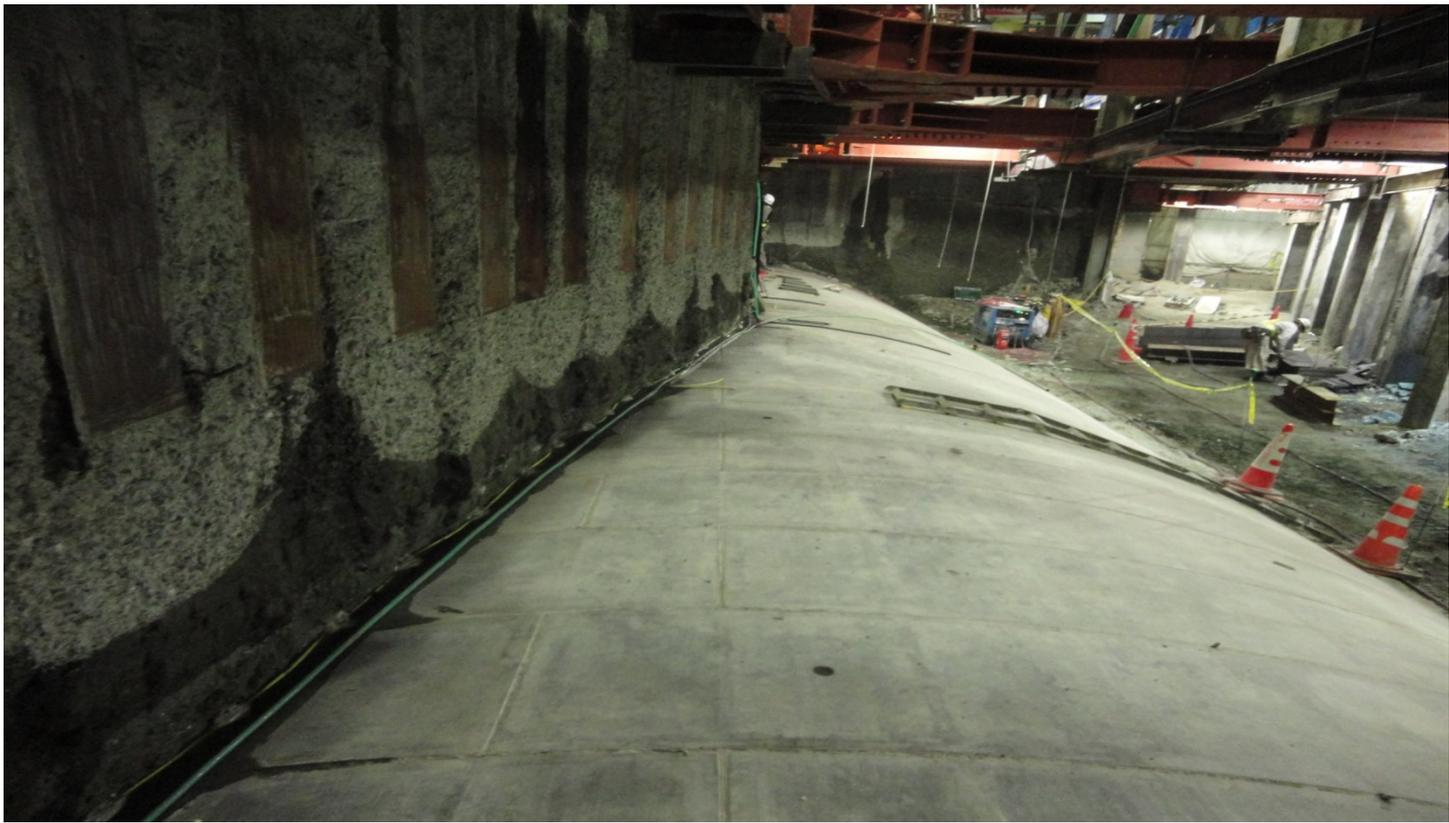
CSM工法で施工したソイルセメント壁(心材入り)
