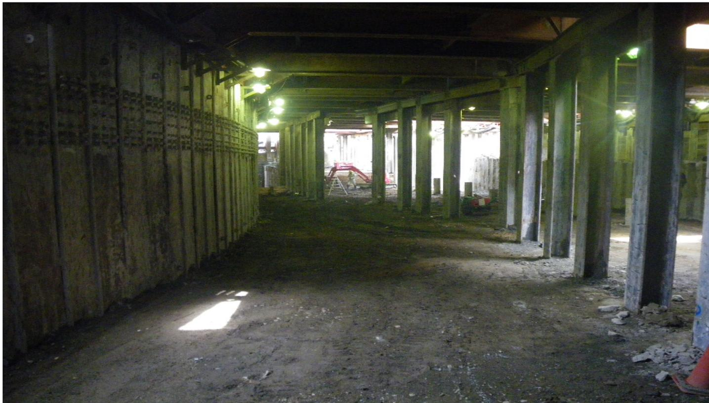
**CSM工法で施工したソイルセメント鋼製連壁壁面**
