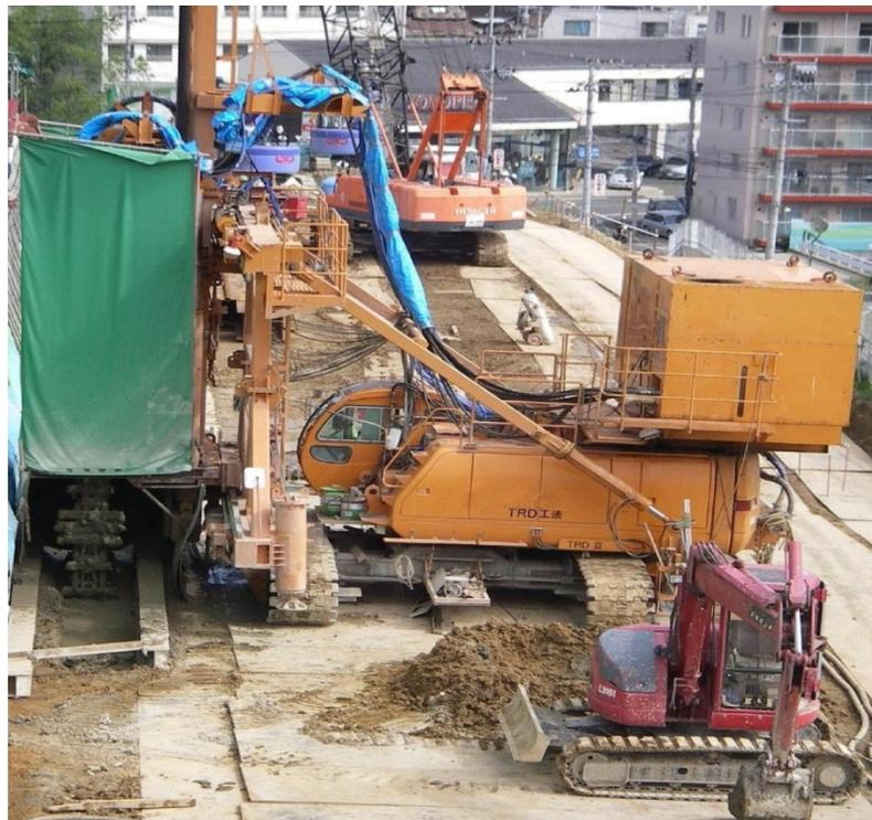
TRD工法施工機械
