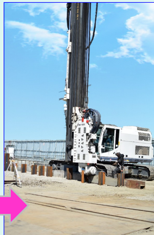
5. 打ち込み完了
