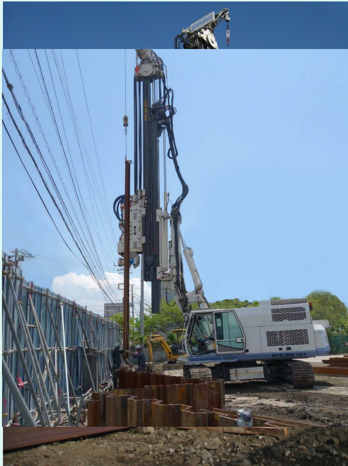
鋼矢板打杭打機
