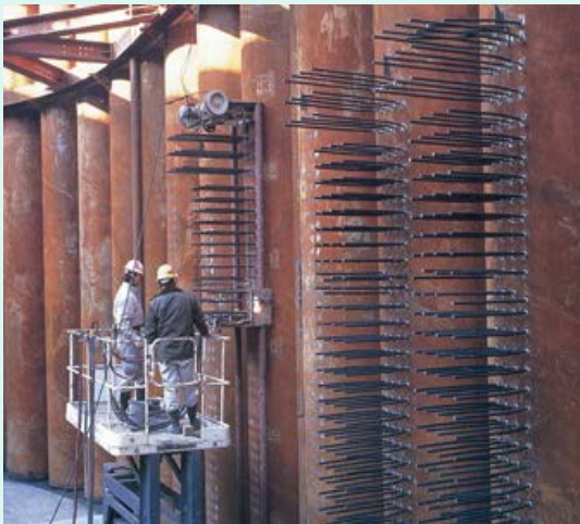
スタッド溶接
