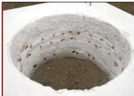
鉄筋コンクリートを切削貫通
