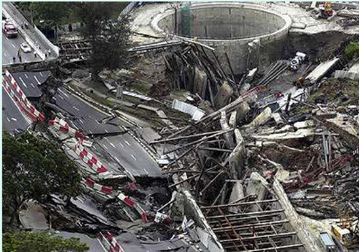
マリンクレイの軟弱地盤での深さ30mの開削工事の事故
