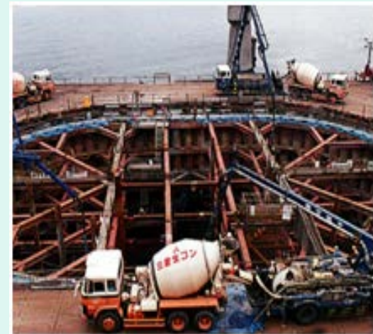
コンクリートの打設
