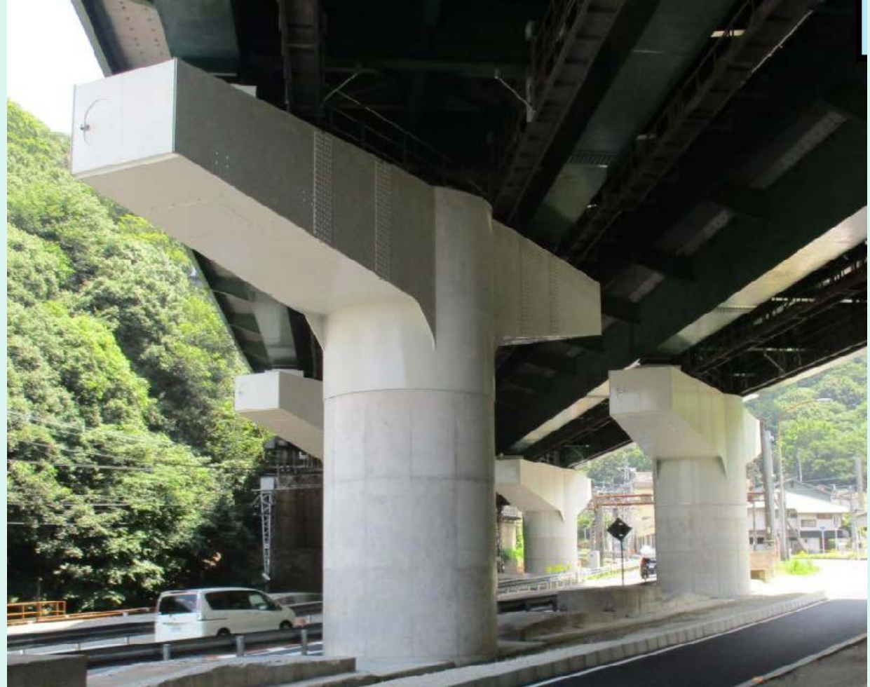
補強後(橋脚・基礎新設)
