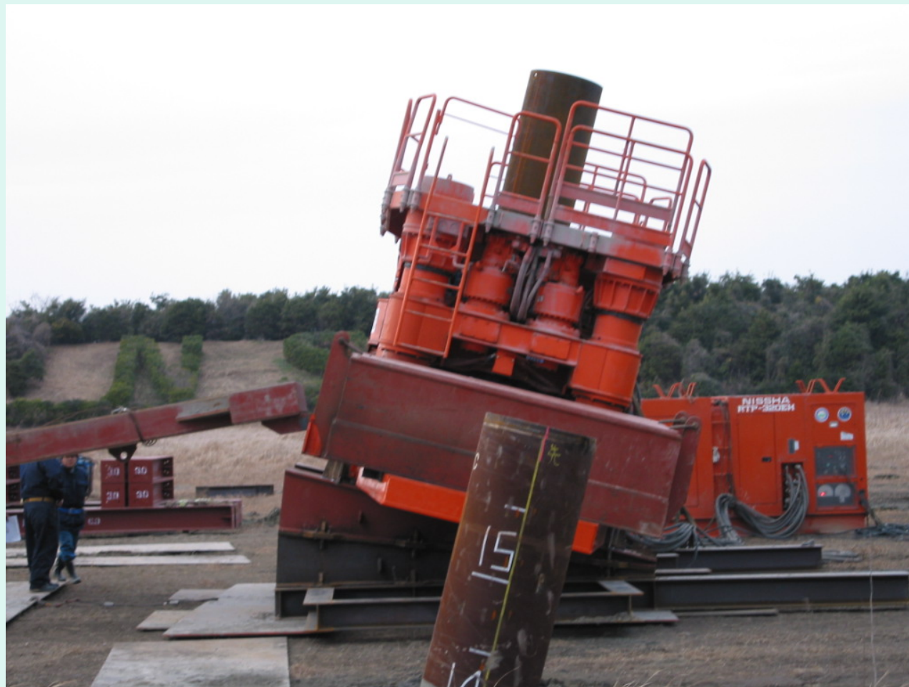
斜杭施工の例(Φ800mm、傾斜角15度)
