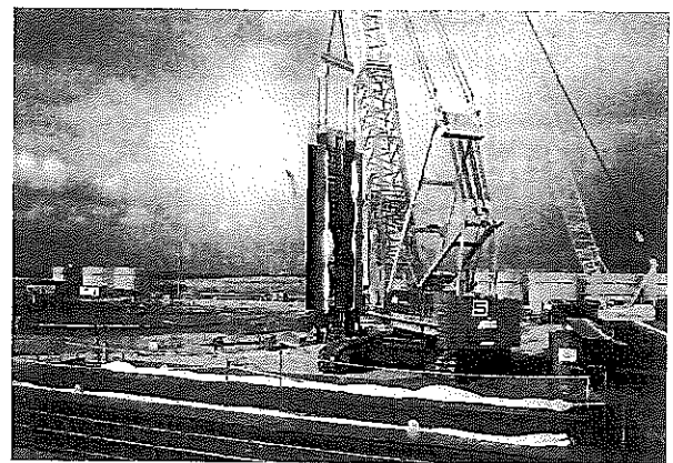
写真-3 450t吊りクローラクレーンによる鉄筋かごの建込み
