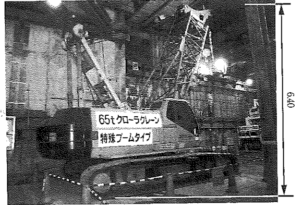
写真-2 応力材建込み状況
