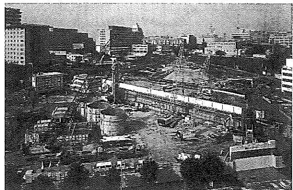
写真-2 施工状況
