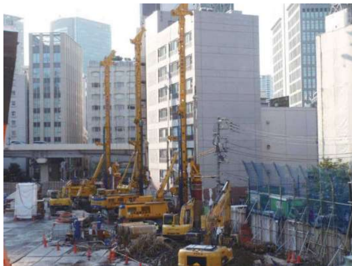
BG 地中支障物撤去工事 (近接複数台施工)
