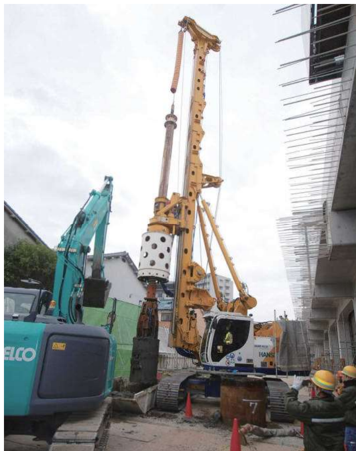
BG 掘削近接工事
