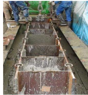
写真-2 NS-BOX建込み後の天端状況
