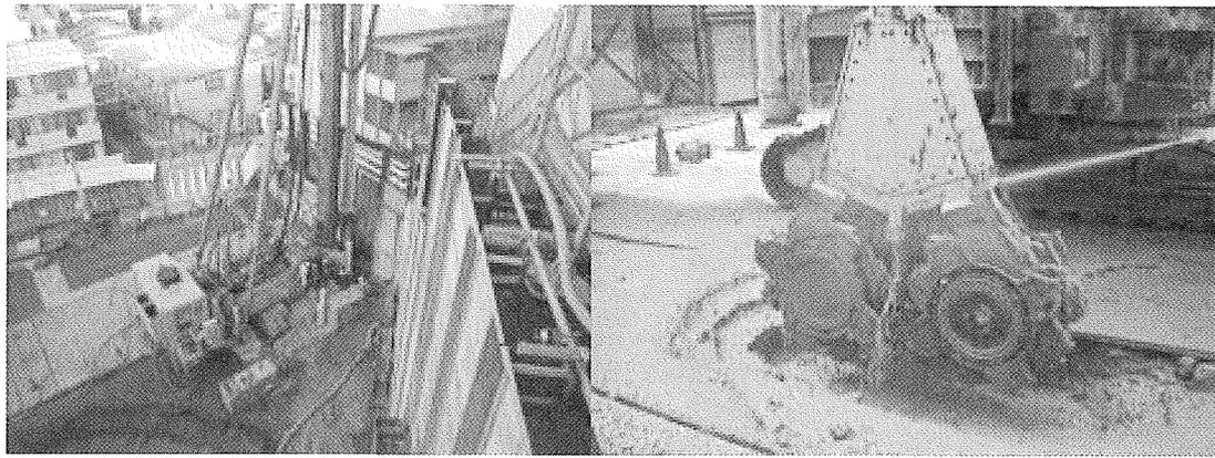
写真-4 CSM 3型施工状況
