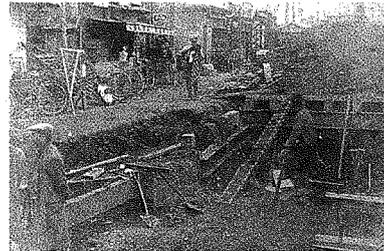
写真-3 路面覆工の施工状況<sup>7)</sup>
