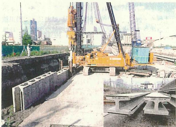
写真-5 H型PC杭の施工状況<sup>4)</sup>
