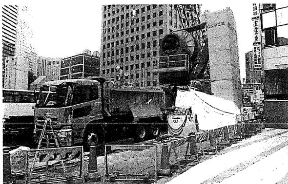
写真-2 鋼製連壁施工状況②
