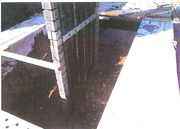
写真-3.3 掘削・攪拌状況<sup>12)</sup>
