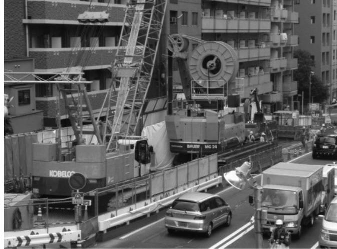
写真5 「クアトロサイドカッター機」の稼働状況
