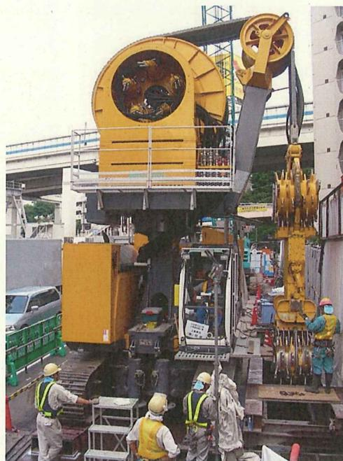
図-2 クアトロサイドカッター機による地中連続壁施工状況
