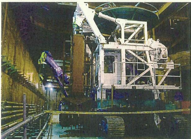
写真-6 地中連続壁施工機械（低空頭型）
