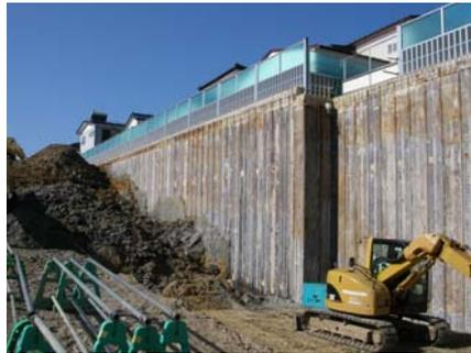
写真-3 鋼製連壁の前面掘削後の状況
