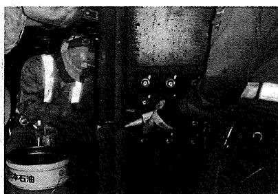
写真-4 鋼製連壁の継手コーキング
