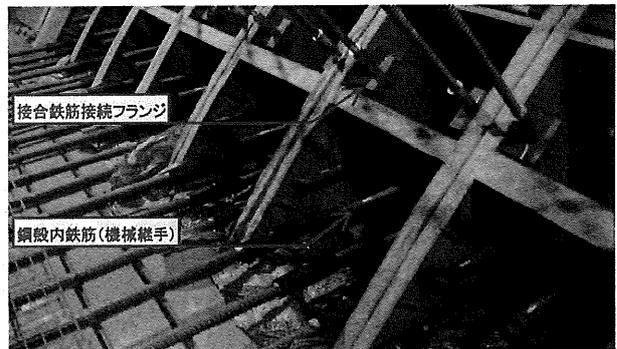
写真-1 特殊鋼殻セグメントに内蔵された鉄筋接続部材
