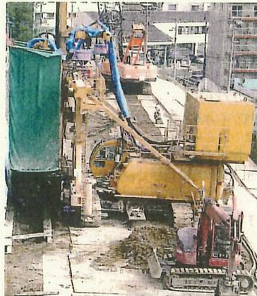
写真-2 TRD工法施工機械
