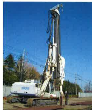
写真 1 施工機械の全景
